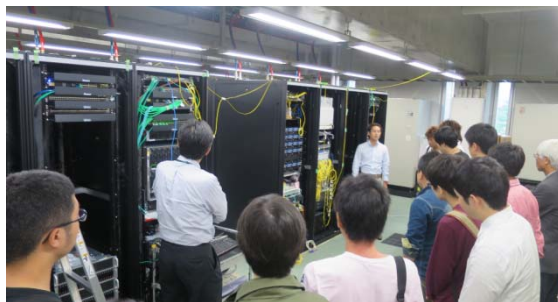
【写真4】サーバルームの見学風景
