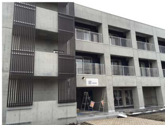
図11: sola 建設中の様子
