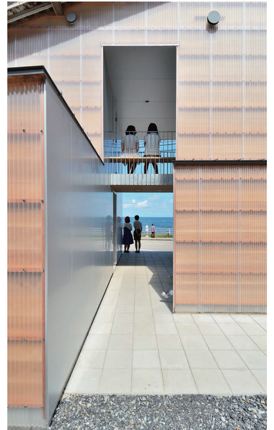
外壁はこの土地特有の仕上げ「杉板下見張り+ポリカ波板（波や風から杉板を保護する）」を踏襲している。「風穴」部分には鈍く光を反射するアルミパネルが張られている
