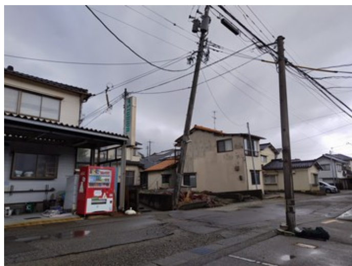
40. 家屋の沈下および傾斜
