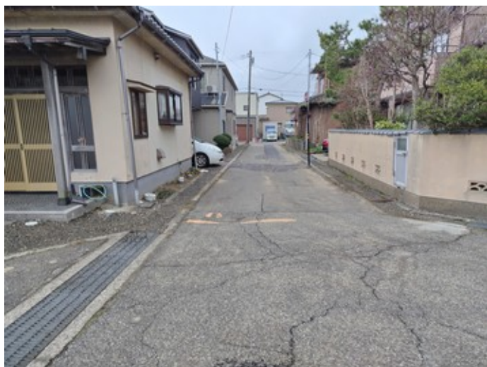
9.平坦部も液状化の痕跡はあるが、大きく動いていない 10.液状化により全体的に沈下している可能性あり
