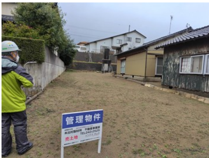
36. 空き地の変状
