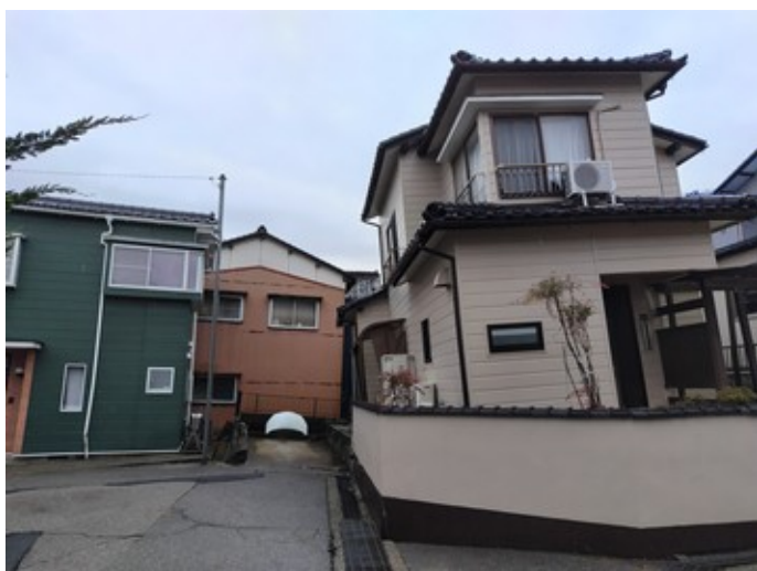
25.家屋の傾き(右手前,真ん中奥ともに)
