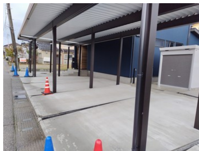
38. コンクリート床板のずれ(電柱傾斜多数)
