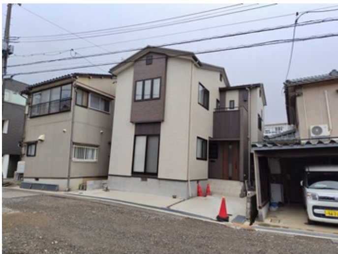
6. 亀裂による家屋被害
