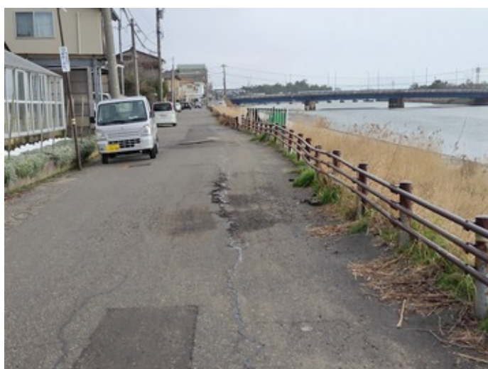
10.河川護岸には被害がない
