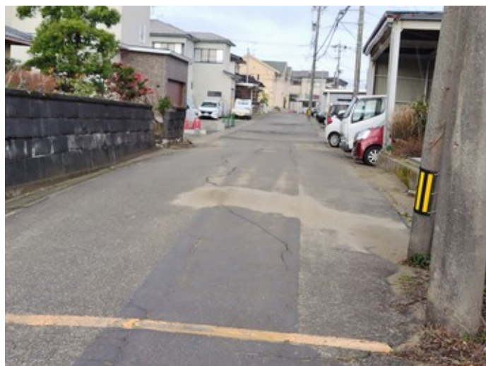
9.平坦部も液状化の痕跡はあるが、大きく動いていない 10.液状化により全体的に沈下している可能性あり
