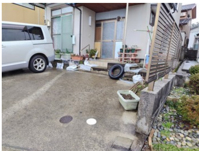
19.家屋と敷地の段差
