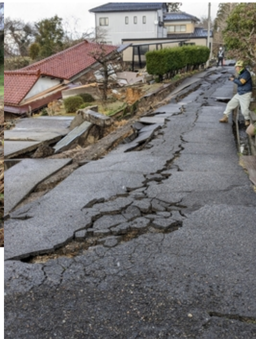
谷埋め盛土の崩落
