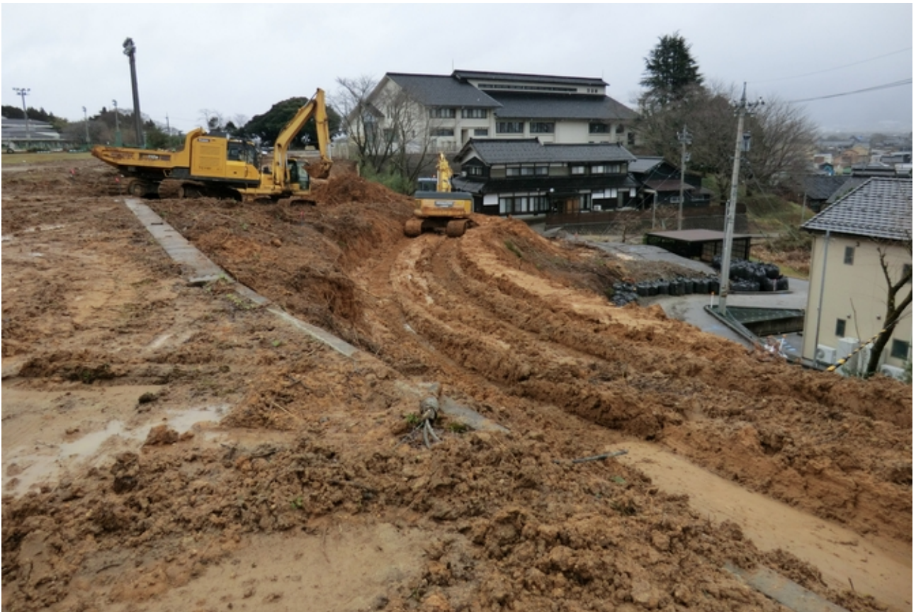
グラウンド下流側の応急対応の様子
