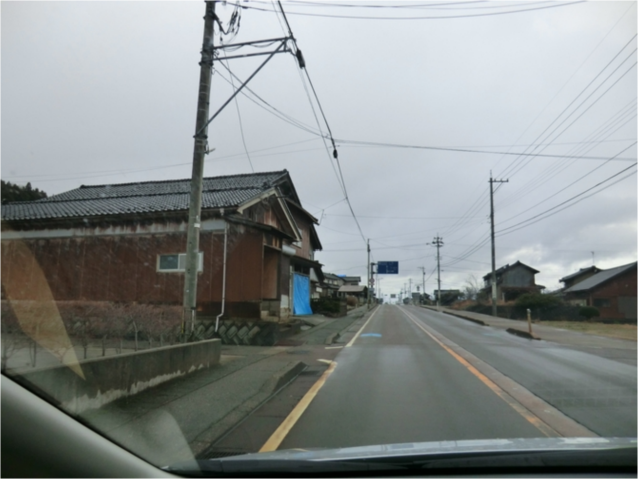
液状化跡多数, 屋根瓦被害, 家屋の変形も多く見られた
