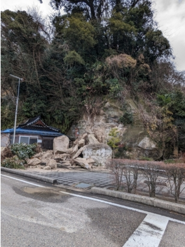
岩盤崩落と道路反対側の液状化による倒壊
