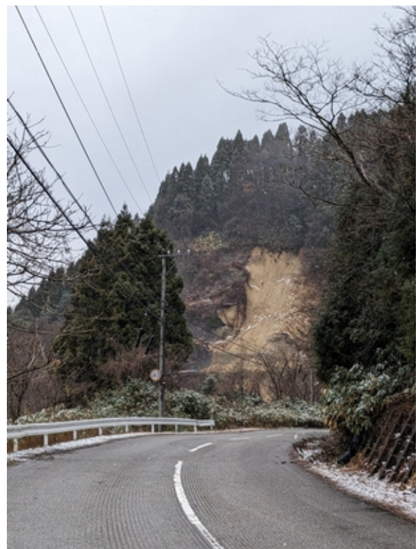
コンクリート吹付上部の崩壊(写真は2箇所別の崩落, いずれも吹付上部)
