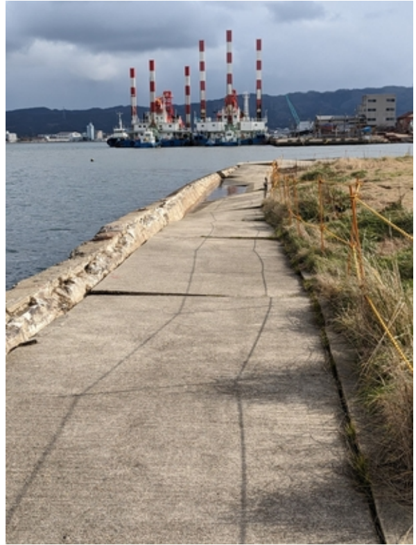
液状化による護岸被害
