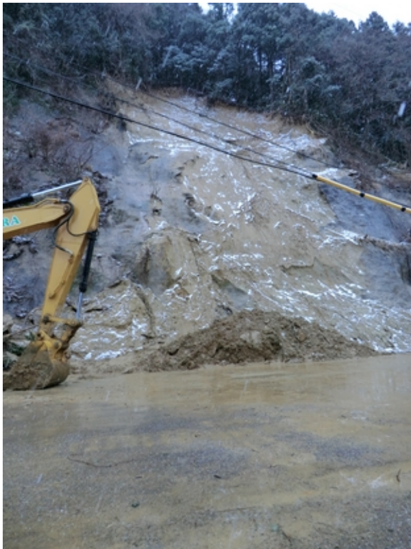
コンクリート吹付上部の崩壊(写真は2箇所別の崩落, いずれも吹付上部)
