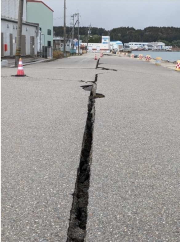
液状化による護岸被害
