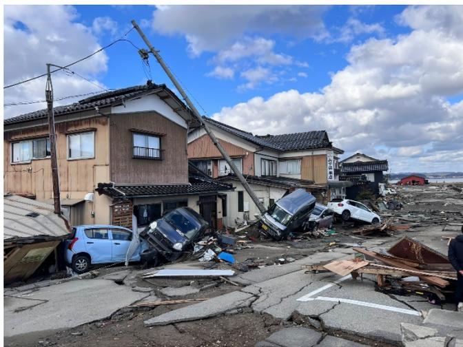
写真1 津波浸水による被害の様子
