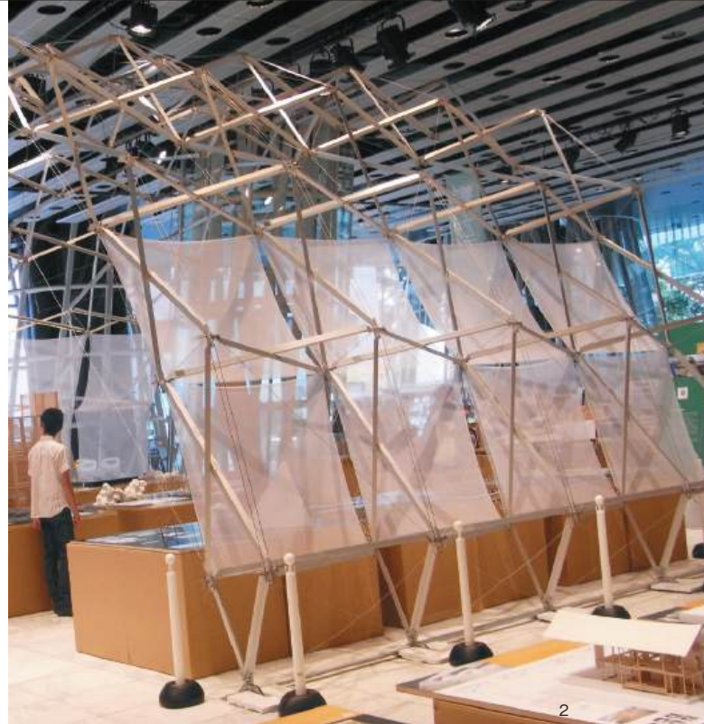
1／スペースフレームと膜構造 2／展開構造
