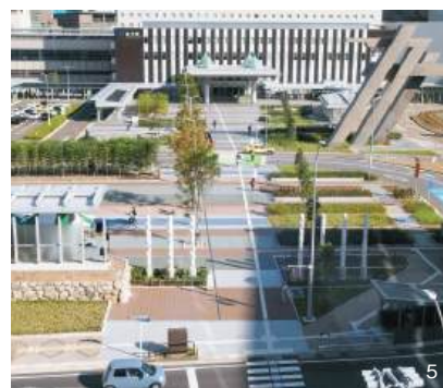
5／ 金沢駅駅西広場(2015年竣工)
