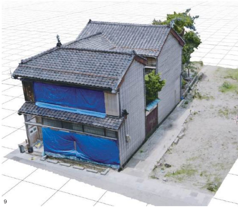
7/自由振動実験の様子(那谷寺) 8/地震被害調査の様子(床下) 9/写真測量による建物のモデル 10/調査に用いるドローン
