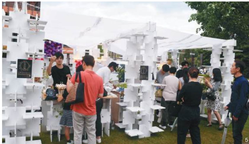
5 / 平板構造で構成したオーガニックカフェの仮設店舗
