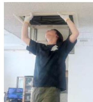
エアコンのフィルターを清掃する学生
