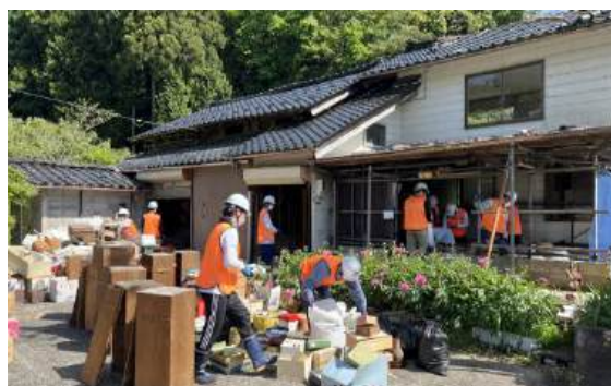
公費解体前の家屋から家財などを搬出するボランティア参加者
