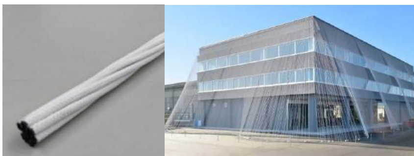
共同開発した「カボコーマ®ストランドロッド」(左)を世界で初めて耐震補強に用いた小松マテールのfa-bo(右)
