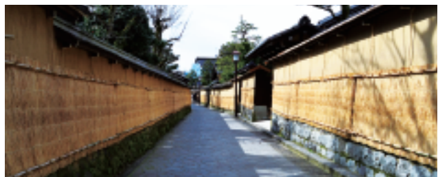
A 景観地区 Historic Area
